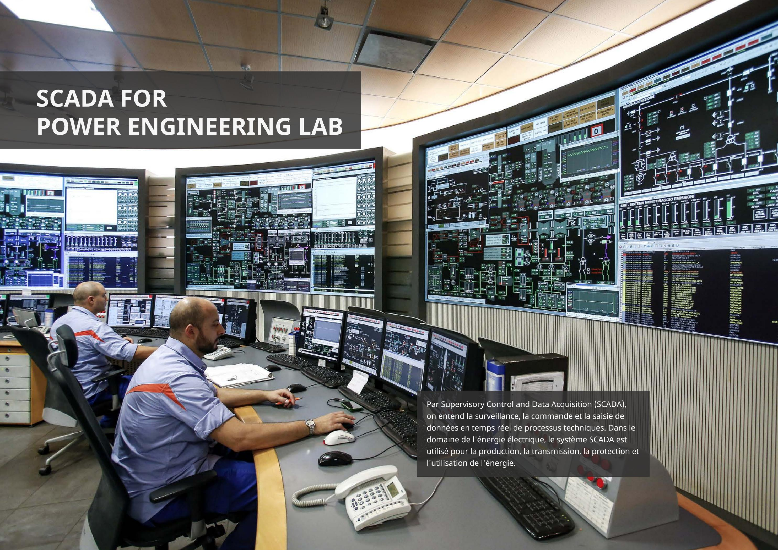
Par Supervisory Control and Data Acquisition (SCADA), on entend la surveillance, la commande et la saisie de données en temps réel de processus techniques. Dans le domaine de l'énergie électrique, le système SCADA est utilisé pour la production, la transmission, la protection et l'utilisation de l'énergie.
