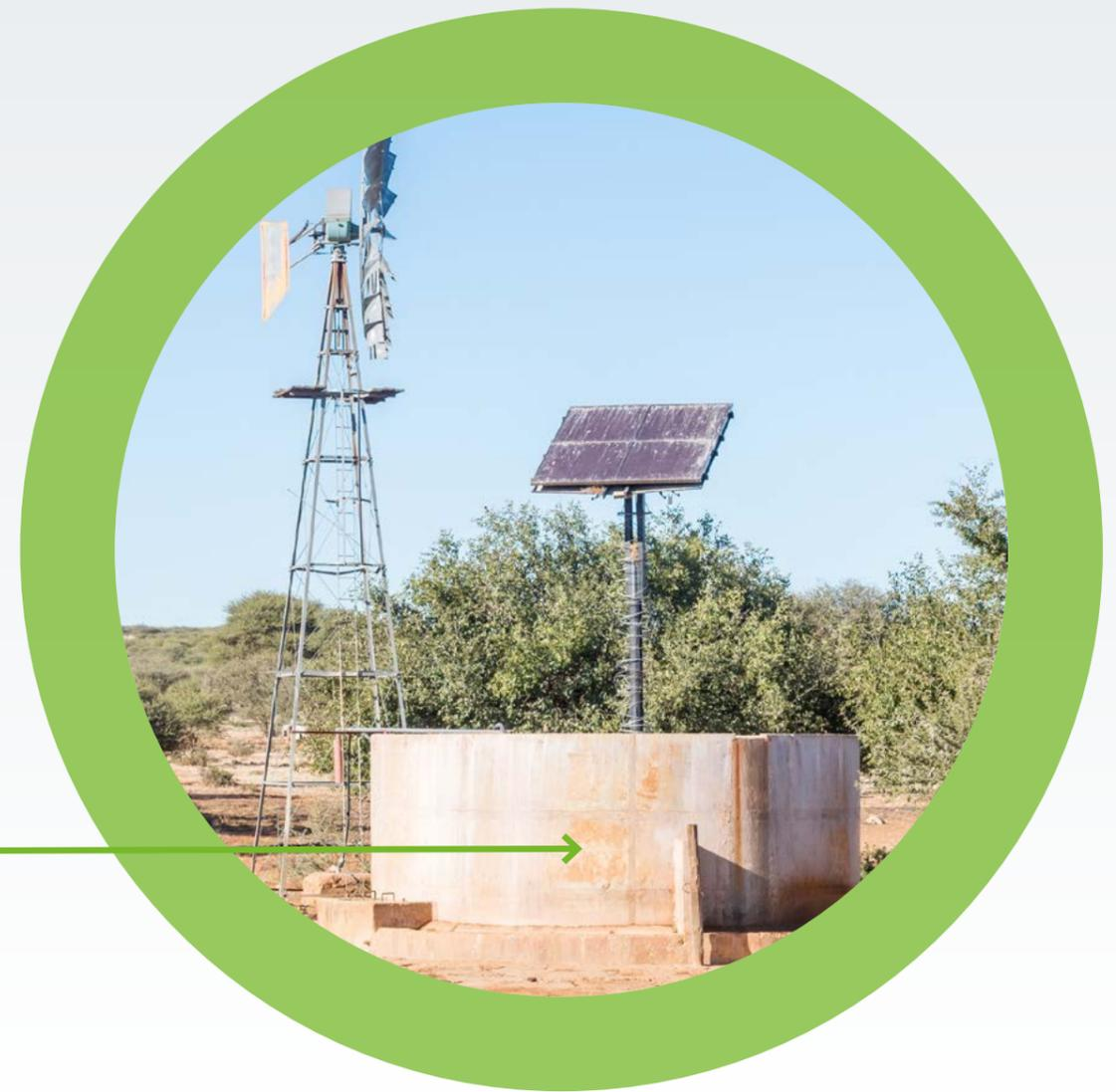
La combinaison du système de pompage solaire avec le système photovoltaïque hybride permet le pompage d'eau de forage même en l'absence de tout rayonnement solaire, étant donné qu'un accumulateur est disponible via le système hybride.
