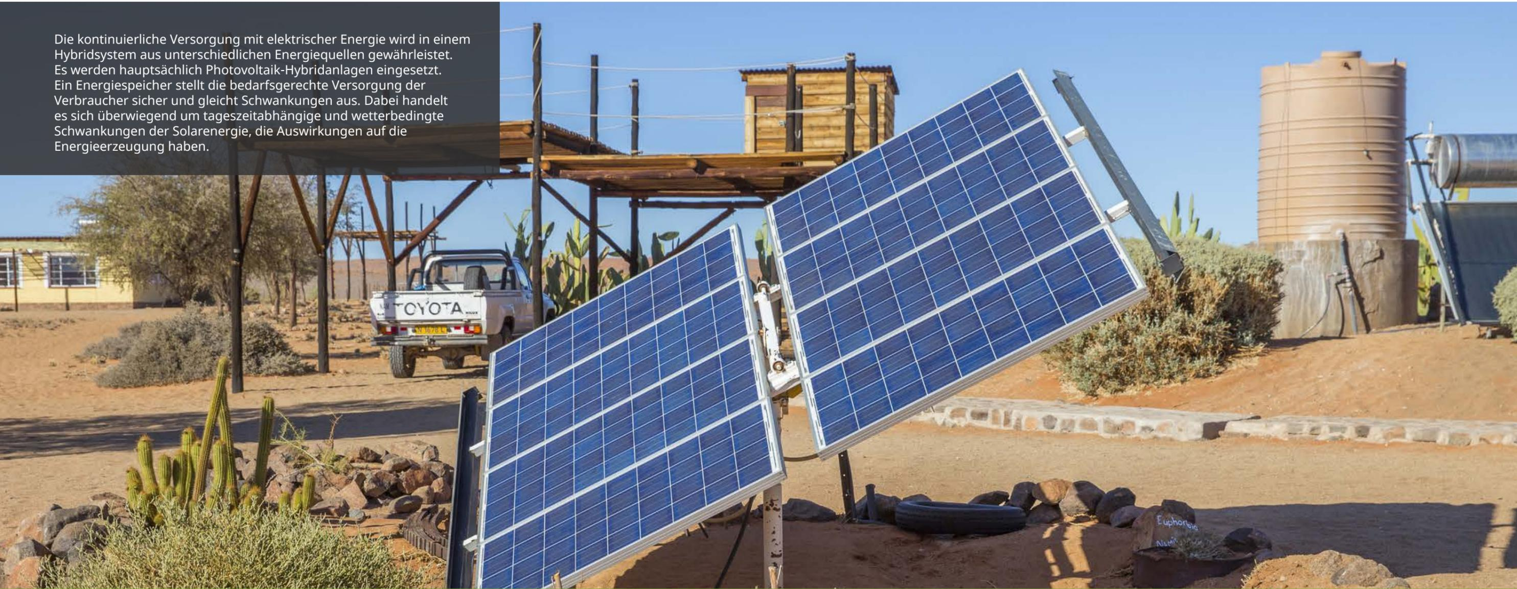
Ein Photovoltaik-Hybridssystem kann mit anderen Energiequellen wie Windkraftanlagen, Wasserkraftwerken und/oder Dieselgeneratoren ergänzt werden. Das kann in Regionen mit weniger intensiver Sonneneinstrahlung sinnvoll sein, um die Schwankungen im Tages- bzw. Jahresverlauf aufgrund einer falsch dimensionierten Photovoltaikanlage auszugleichen. In sonnenreichen Regionen kann ein Hybridsystem die Versorgungssicherheit und -unabhängigkeit erhöhen.
