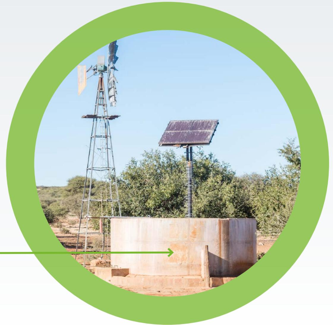
Die Kombination des Solarpumpensystems mit dem Photovoltaik-Hybridsystem ermöglicht die Förderung von Brunnenwasser auch ohne Sonneneinstrahlung, da über das Hybridsystem zusätzlich ein Batteriespeicher zur Verfügung steht.
